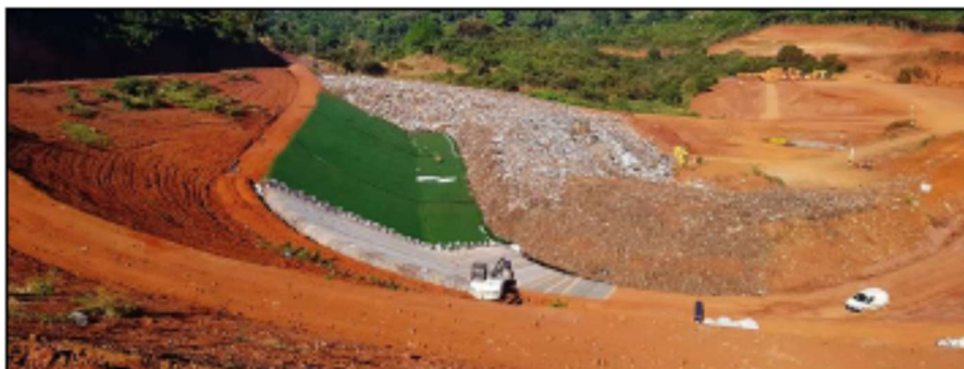
Figure 11 : ISDND de Dzoumogné : casier 1 (juillet 2017) et installations de traitement des lixiviats et du biogaz (source STAR URAHAFU)
